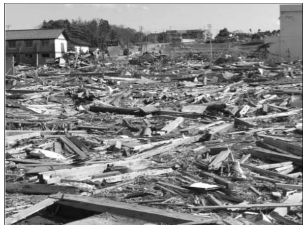
写真2 相馬市磯部地区の被災状況（2011年3月26日／Yahoo! JAPAN 東日本大震災写真保存プロジェクト）
